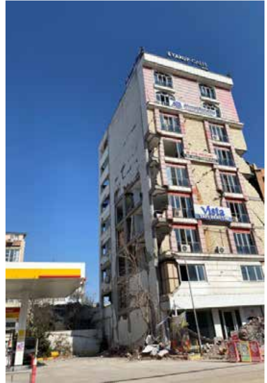
Fotoğraf 3: Adıyaman'da altı işyeri olan yıkılmış çok katlı binalar
