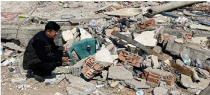
Fotoğraf 2: Adıyaman'da yıkılan bina enkazı
