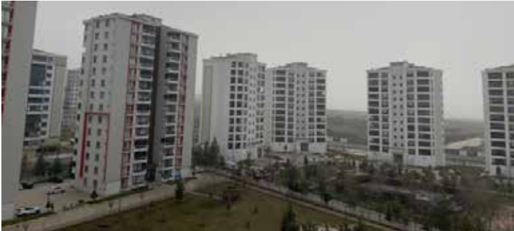
Fotoğraf 1: Diyarbakır'dan çok katlı binalar
