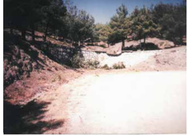
Şekil 9. Gökdere meyil ıslah barajı (2000)
