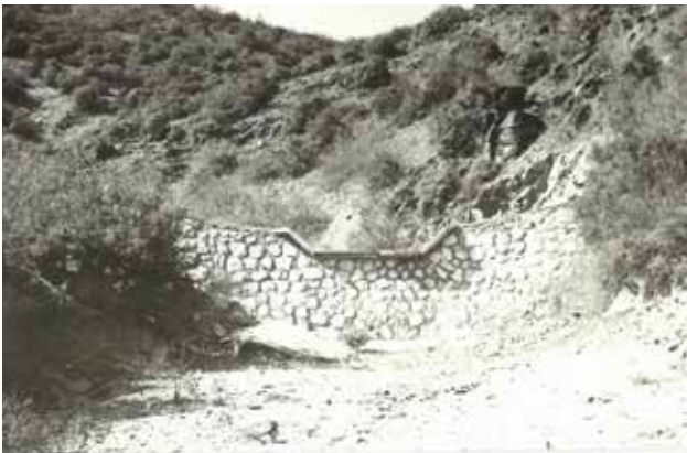
Şekil 12. Karaağaçlı Deresi Meyil Islah Barajı (1964)
