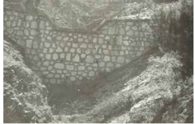
Şekil 11. Gürgenli Dere meyil ıslah barajı (1964)
