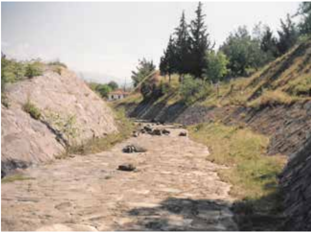
Şekil 4. Döme Deresi Çevirme Kanalı (2004) (Kanalda rüsubatın olmaması çalışmaların başarıya ulaştığını gösteriyor).
