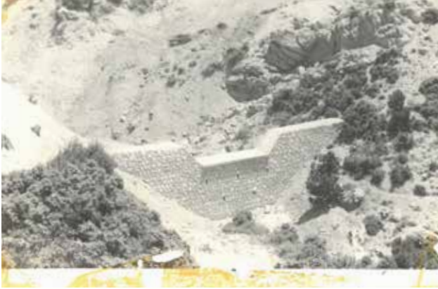
Şekil 10. Korazlı Dere meyil ıslah barajı (1964)
