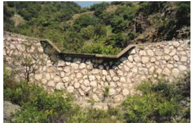
Şekil 13. Harçlı Barajın 2004 yılındaki durumu
