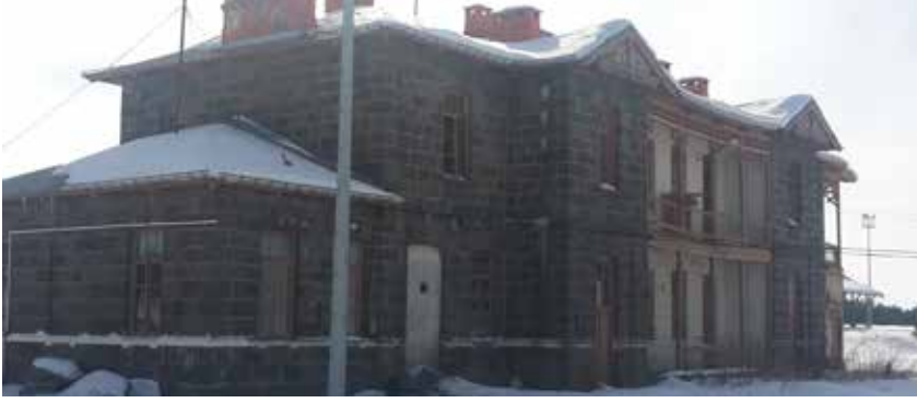
Fotoğraf 6. Tarihi Selim Tren İstasyonu binasının dış görünüşü
