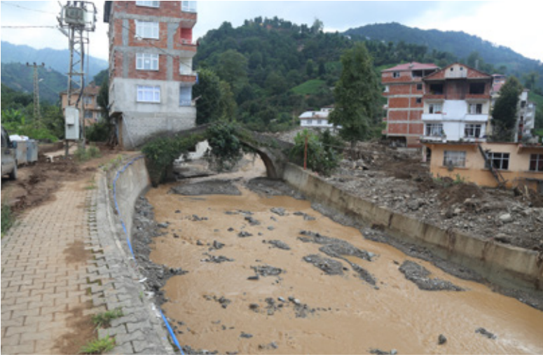
Şekil 18. Selin Hopa İlçe Merkezinde oluşturduğu tahribatlar.
