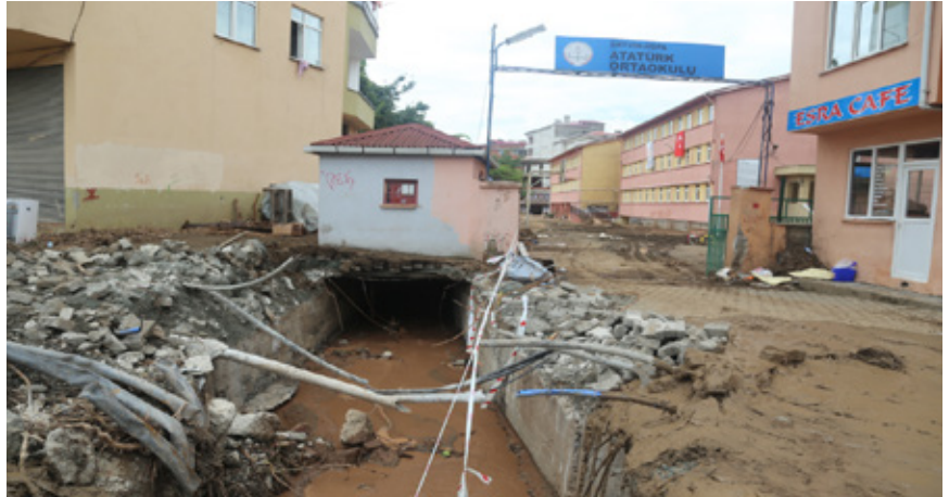
Şekil 17. Selin Hopa İlçe Merkezinde oluşturduğu tahribatlar.
