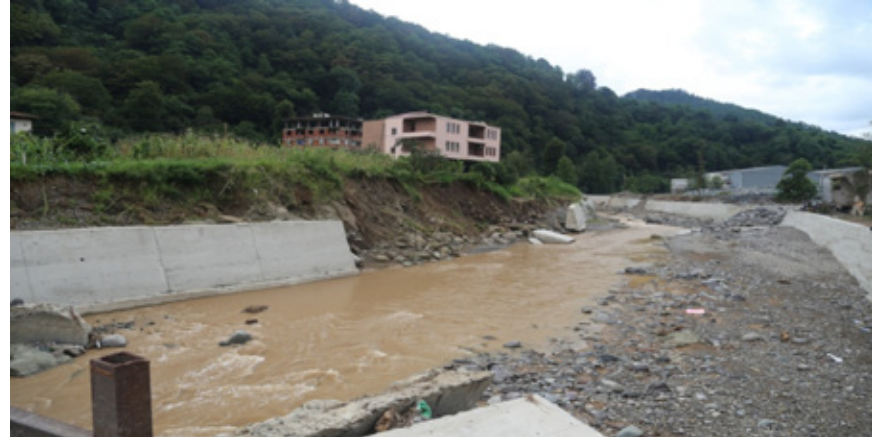
Şekil 11-12. Teknik açıdan yeterli olmayan sanat yapılarının oluşturduğu tahribatlar
