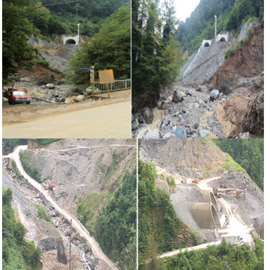
Şekil 15. Cankurtaran Tünelinin hafriyat atıklarının sel suları ile taşınması.
