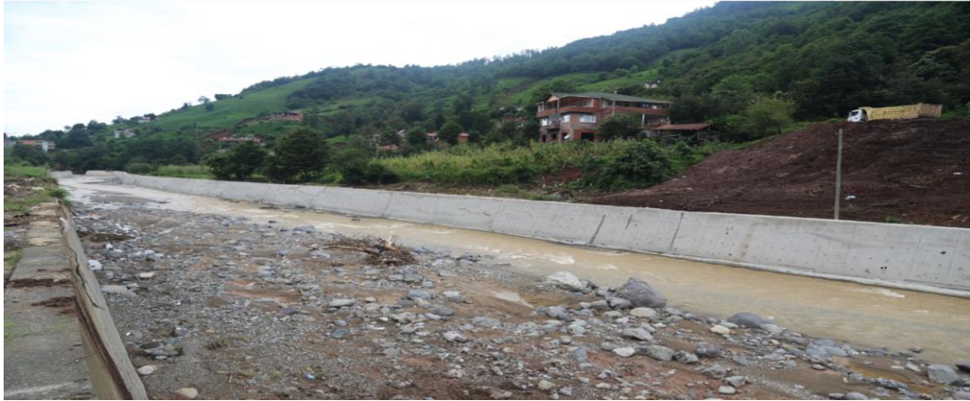
Foto-13: Teknik açıdan yeterli olmayan istinat duvarları.
