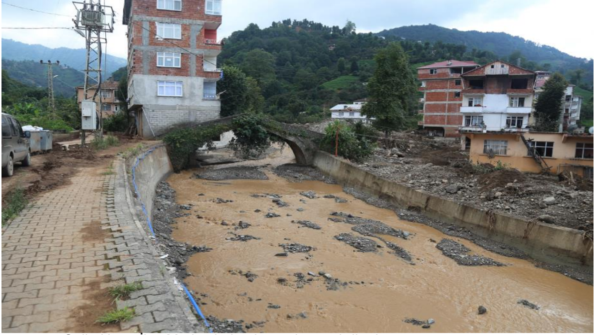
Foto-18: Selin Hopa İlçe Merkezinde oluşturduğu tahribatlar.
