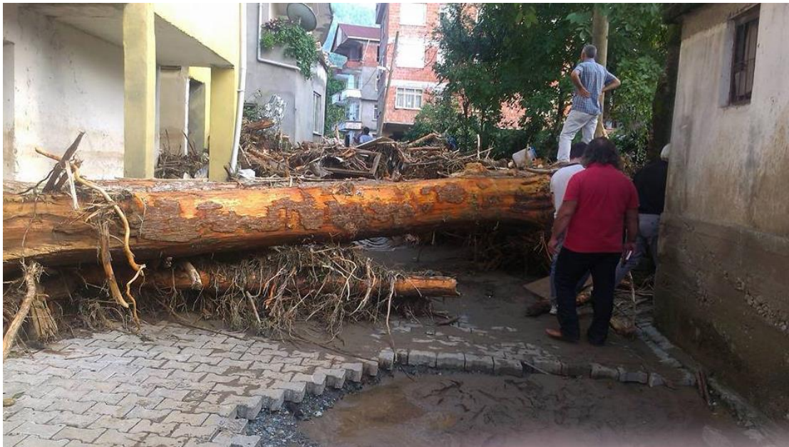
Foto-19: Selin Hopa İlçe Merkezinde oluşturduğu tahribatlar.
