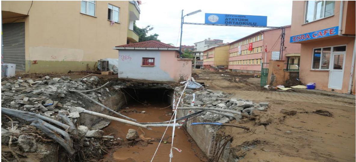
Foto-17: Selin Hopa İlçe Merkezinde oluşturduğu tahribatlar.
