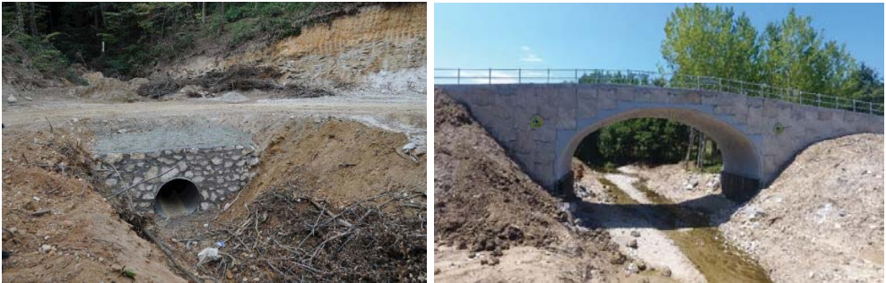
Şekil 7. Ülkemizde orman yollarında ilk defa kullanılan çelik menfez ve çelik köprü (Çatalca ve Vize)
