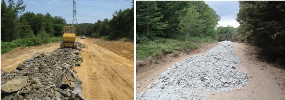
Şekil 5. Orman yollarında üst yapı malzeme seçimindeki hatalar
