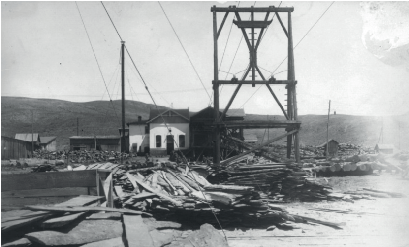
Şekil 82. Havai hattın fabrika yakınlarındaki görünümü (Bozüyük Şehir Müzesi)
