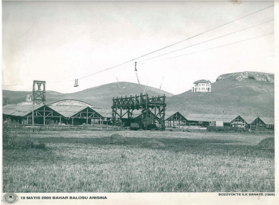
Şekil 76. Kereste fabrikası (ön planda havai hat ve arka planda İbrahim Bey Köşkü)
