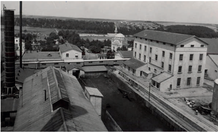
Şekil 104. Alpullu Şeker Fabrikası (Ayşe Kopuz, Tuğçe Tetik)
