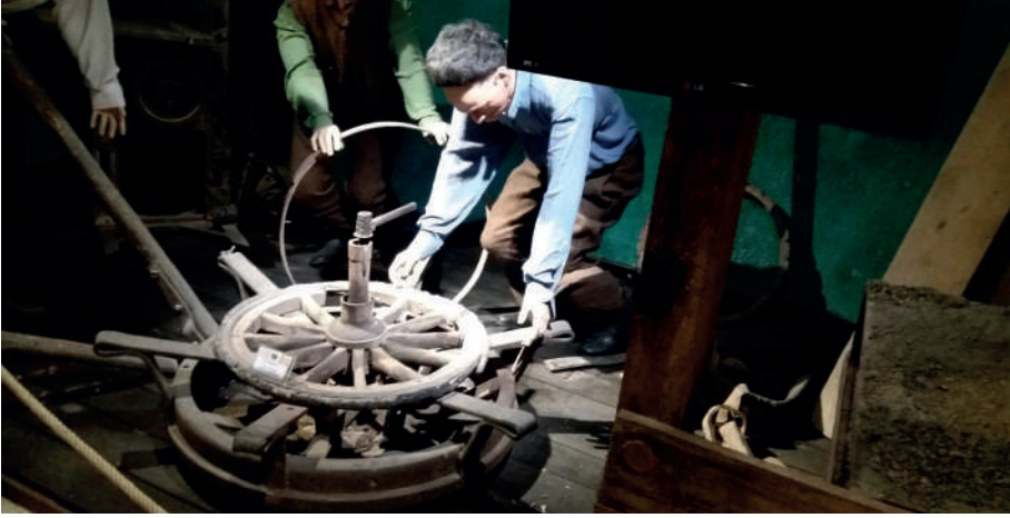
Şekil 17. Ahşap top ve kağını tekerlekleri yapımı
