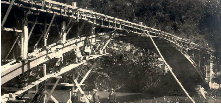
Şekil 46. Bartın-Kirazlık köprüsü yapımı- 1928 (Karayolları Genel Müdürlüğü)
