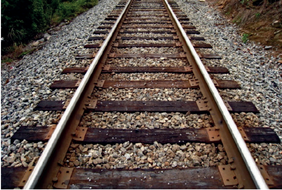
Şekil 6. Demiryolunda travers
