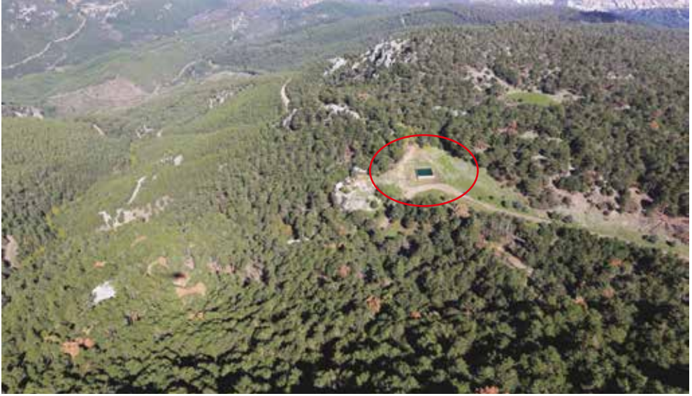
Şekil 5: Yangın havuzunun görünümü
