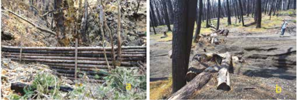
Şekil 1. a. Kütük barajı (M Arianoutsou), b. Vezüv yanardağı eteklerinde orman yangını sonrası yanık ağaçlarla inşa edilen kütük tuzaklarla yüzeysel akış ve sedimentasyon kontrolü (HE Çelik)
