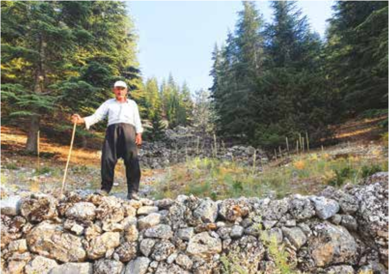
Resim 21: Göksun Korkmaz Köyü Erozyon Kontrolü Projesi ve kuru duvar eşikler. 46 yaşında
