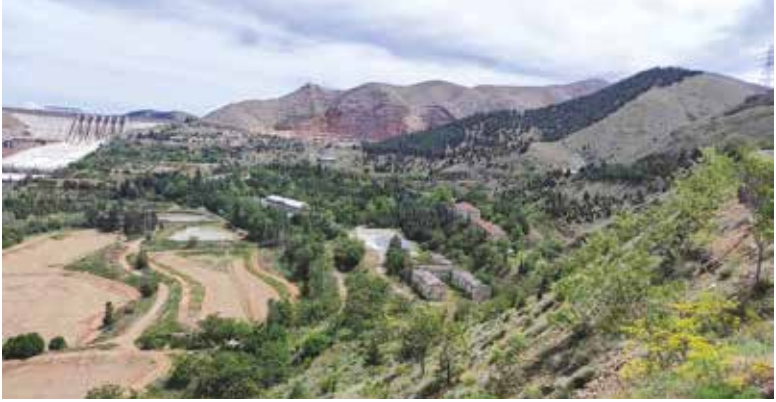
Resim 23: Keban Barajı sol sahil kret çevresi ağaçlandırması
