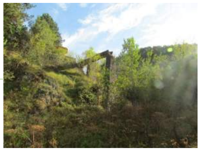
Resim 75. Çamkoru'daki Santralin Günümüzdeki Durumu
