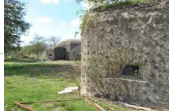
Resim 72. Çakmak hattında beton barınaklar
